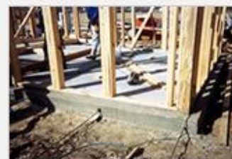
Fijar la solera al concreto
